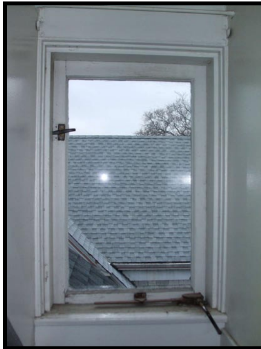
10.) 3 rd floor bathroom casement window
